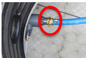
Fig-22 : Raccordement côté réacteur biologique
